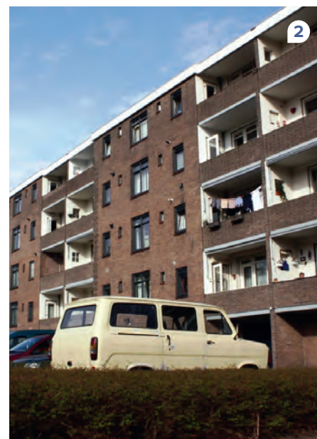
1 // Het nieuwe aanzicht met uitstekende balkons met slanke glazen schermen. 2 // Het oude aanzicht, met loggia's met een gemetselde borstwering.
